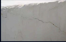
Uygulama Öncesi Blok
